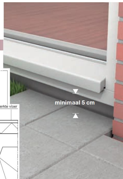
Afstand onderkant kozijn - bestrating
